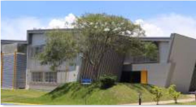
Fachada principal de las nuevas instalaciones del CICA
